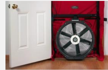
Verbetering van de luchtdoorlaatbaarheid
