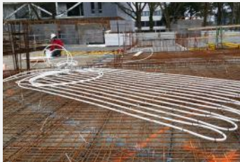
Activering van de betonkern
