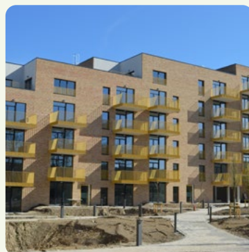
Grenouillette à Haren : 66 logements sociaux pour Le Logement Bruxellois
