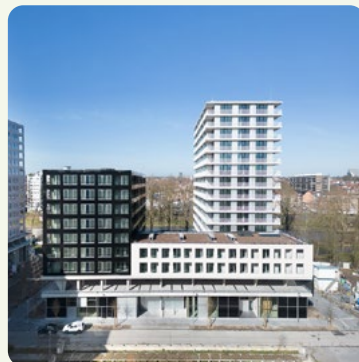
City Dox Lot 5 à Anderlecht : 171 logements sociaux pour le Foyer Anderlechtois (acquisition clé sur porte)
