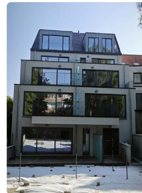
Paris à Evere : 7 logements sociaux pour Everecity (acquisition clé sur porte)
