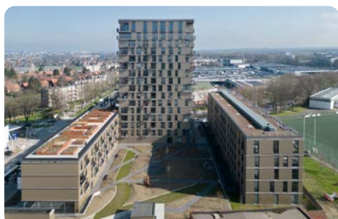
Evereast - The Wood à Evere : 54 logements sociaux pour Everecity (acquisition clé sur porte)
