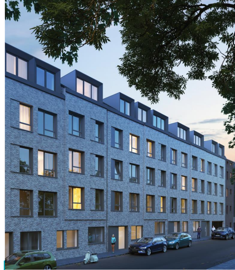
Leo 33 woningen Leopoldstraat, 1 1020 Laken Smarthome Compromis : 2022
