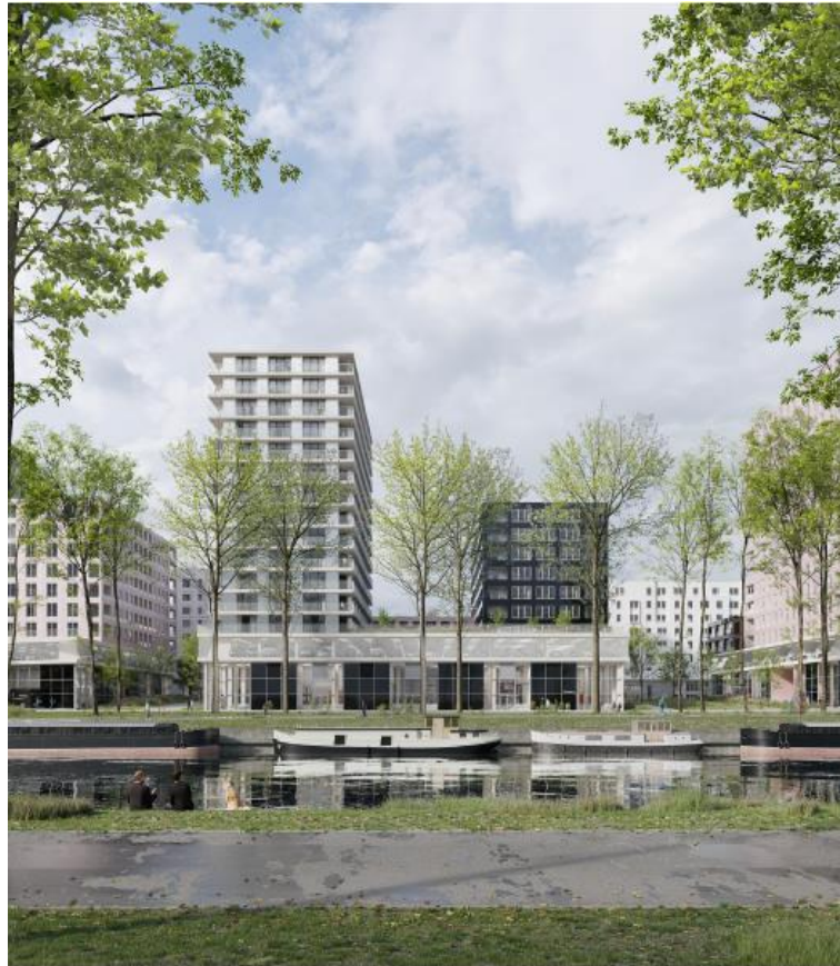
City-Dox Kavel5 171 woningen Vaartdijk 1070 Anderlecht Atenor Compromis : 2022
